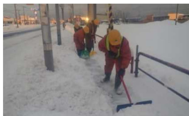
電柱の周辺は人力除雪となるため、効率が低下（国道36号 苫小牧市）
