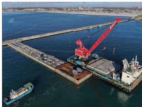
釧路港西港区 土砂処分場整備状況
