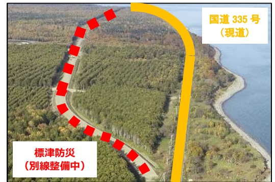
国道335号 標津防災
