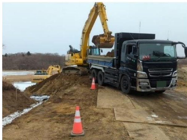
低騒音機械による施工状況(バックホウ)
