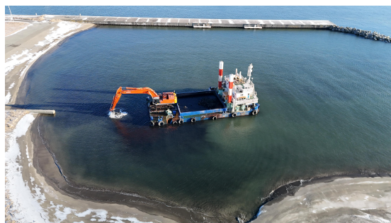
泊地浚渫状況
