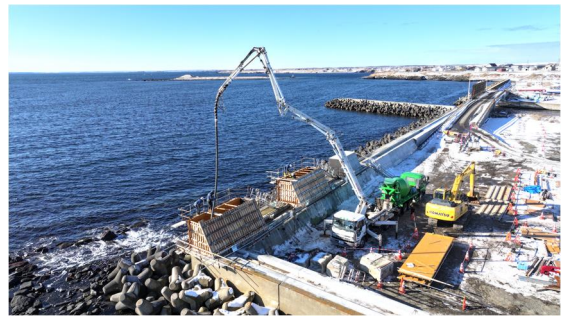
護岸嵩上げ整備状況
