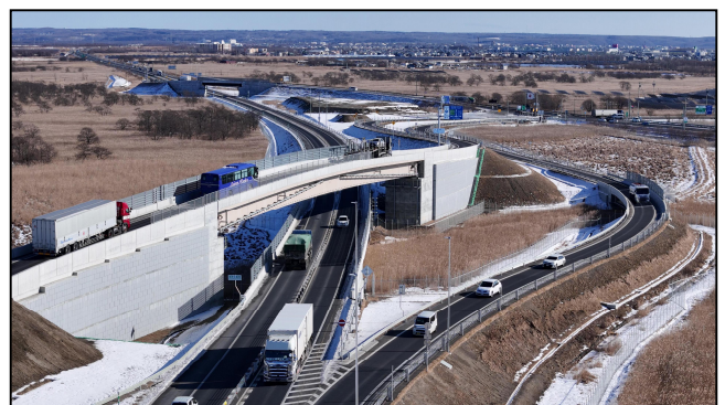
道東自動車道 釧路西IC（令和6年12月22日開通）
