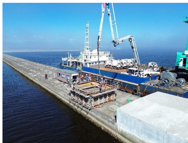
釧路港西港区 新西防波堤 上部コンクリート打設状況
