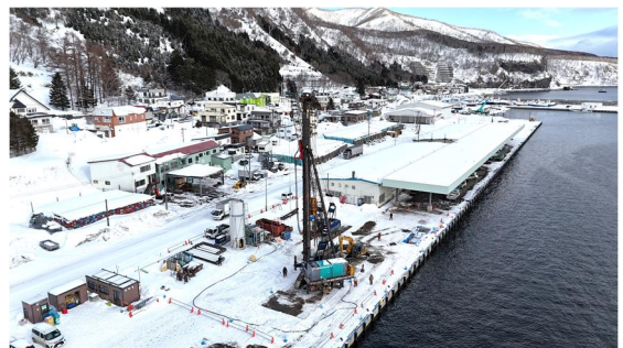
屋根付き岸壁整備状況
