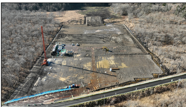
国道44号 尾幌糸魚沢道路
