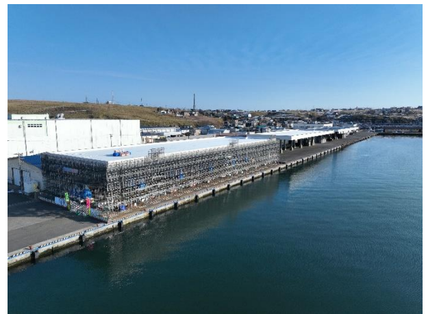
根室港花咲 ハナサキ 港区 屋根付き岸壁整備状況
