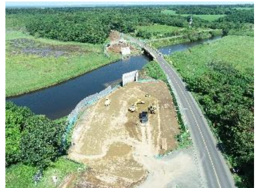
国道44号 根室防雪
