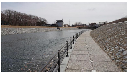
釧路川の河道整備状況（掘削、護岸）
