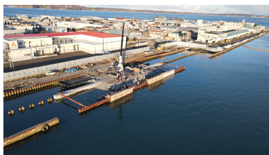
岸壁嵩上げ整備状況
