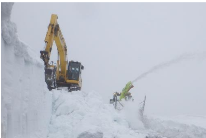
③道路上に堆積した雪のロータリ除雪車等を用いた除雪作業
