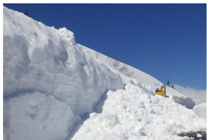
③道路上に堆積した雪のロータリ除雪車等を用いた除雪作業
