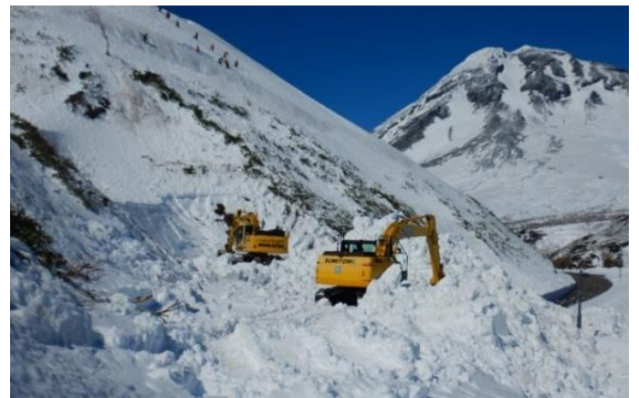
②除雪作業前の雪割作業と雪崩防止のための法面除雪
