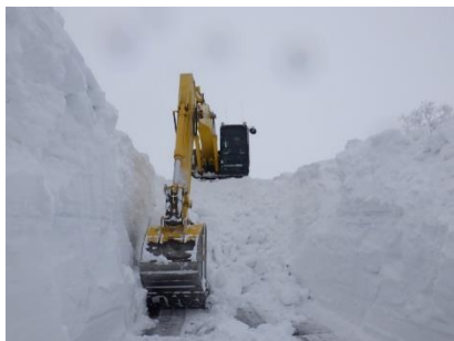
油圧ショベルによる作業状況
