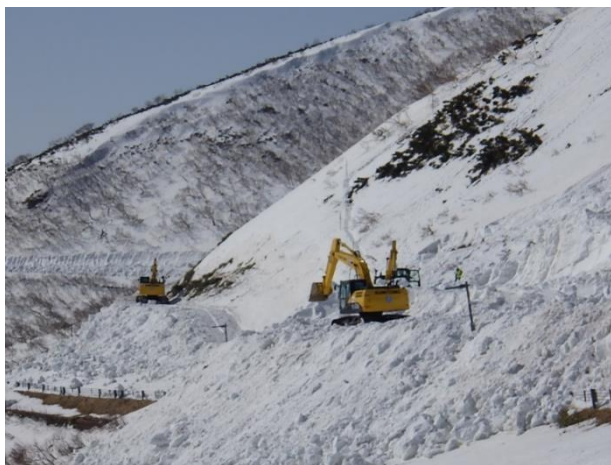
油圧ショベルによる斜面除雪
