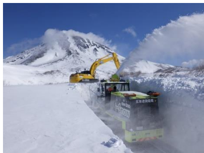
ロータリ除雪車による作業状況
