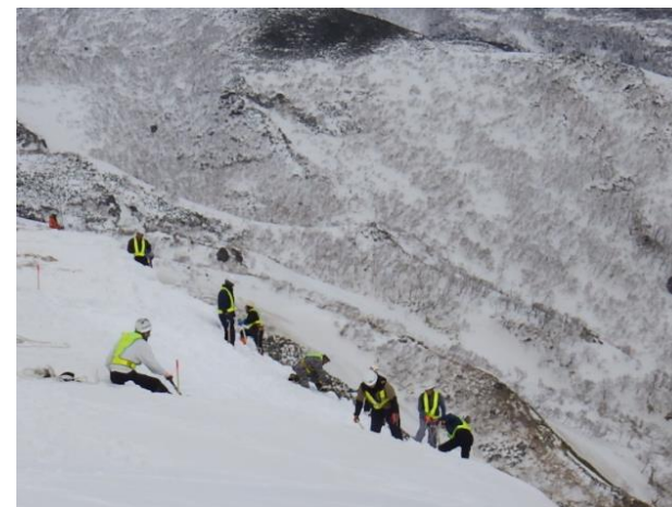
人力による雪庇処理、斜面除雪
