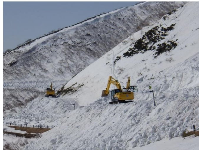
油圧ショベルによる斜面除雪
