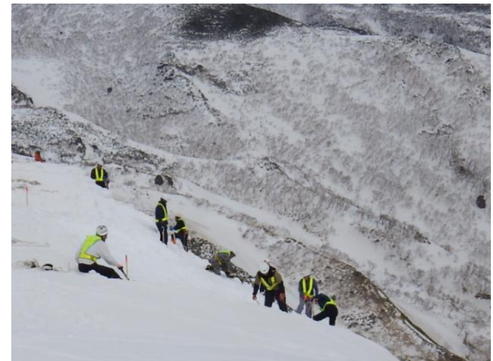
人力による雪庇処理、斜面除雪
