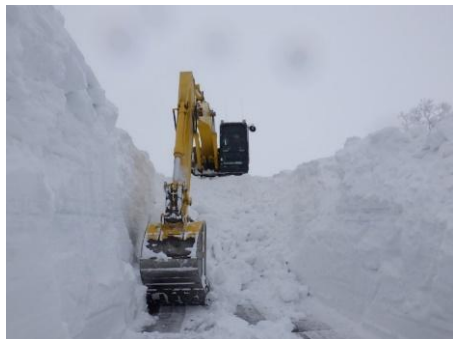
油圧ショベルによる作業状況
