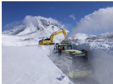
ロータリ除雪車による作業状況
