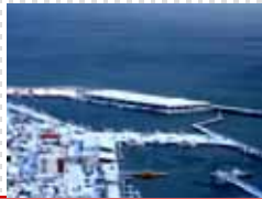
〔羅臼漁港屋根付岸壁〕
