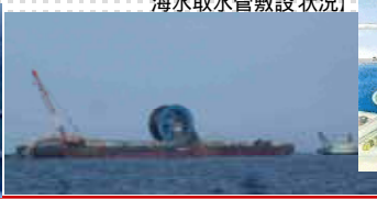
〔羅臼漁港低温清浄海水取水管敷設状況〕
