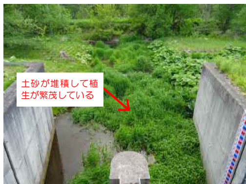
目的別巡視 (樋門の土砂堆積状況の確認)
