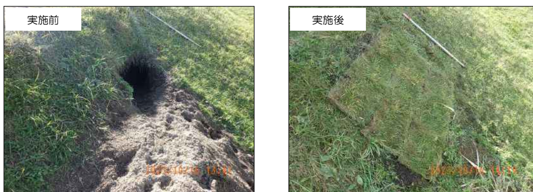
堤防補修実施状況
