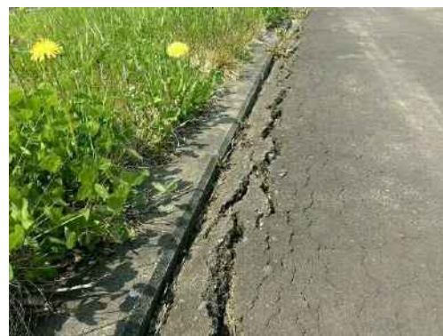
目的別巡視 (堤防天端舗装の破損状況の確認)
