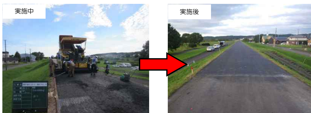
天端補修状況
