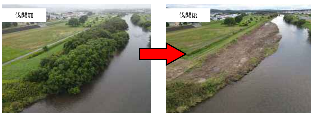
樹木伐開状況
