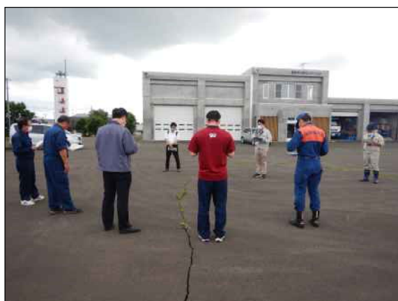
合同点検の状況（令和5年7月3日）
