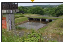
R6.7 釧路川 富士樋門
