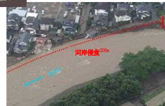
河岸侵食に伴う 家屋倒壊等
