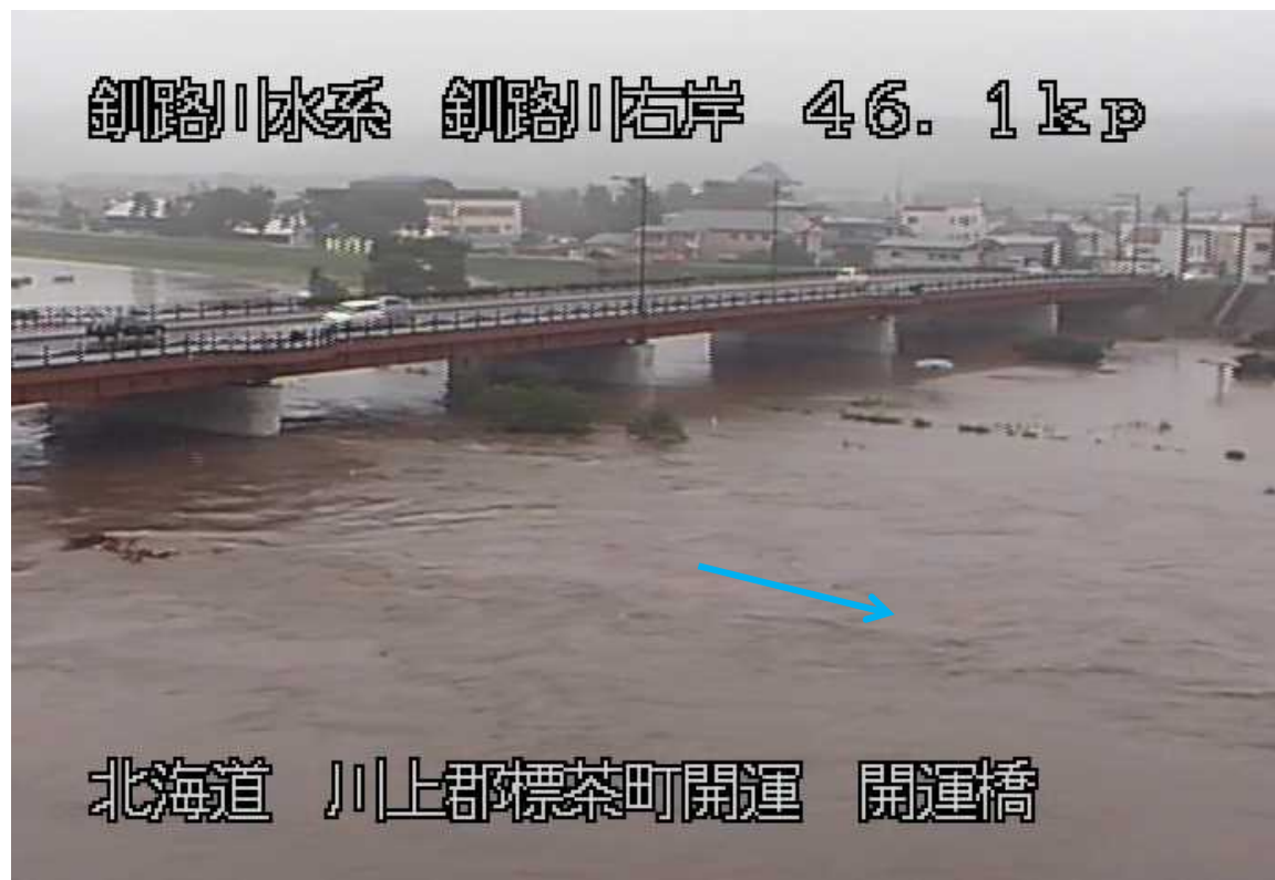
平成28年8月21日 台風第11号等 釧路川 開運橋の様子（標茶水位観測所付近）
