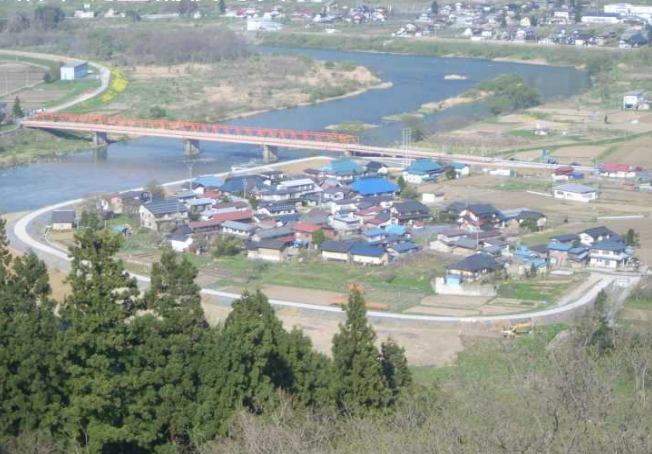
輪中堤整備後写真
