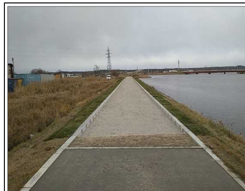
釧路川の堤防天端舗装の状況
