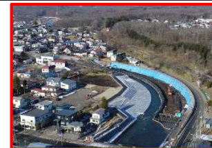
釧路川流域の市街地を守る堤防整備・河道掘削 （釧路開発建設部、釧路総合振興局）
