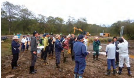
ヌマオロ地区旧川復元事業実施箇所
