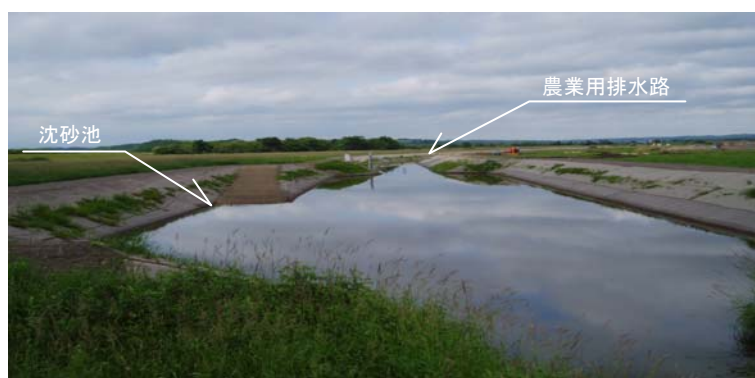
沈砂池の写真（イメージ）
