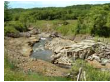
写真 河床低下区間の状況
