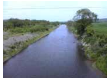
写真 光橋付近の河道状況
