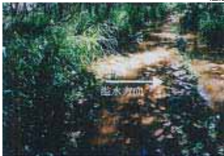
7 月 12 日の溢水状況 (右岸 KP0.77)
