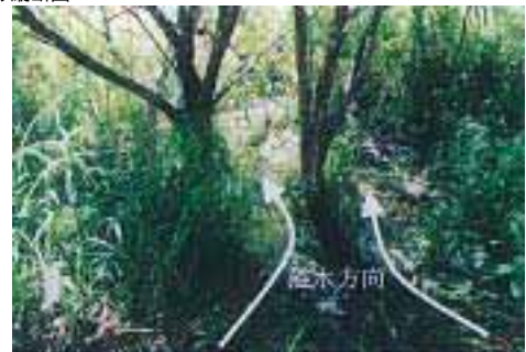
7 月 12 日の溢水状況 (右岸 KP0.68)
