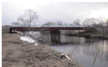
■仮橋架橋状況
