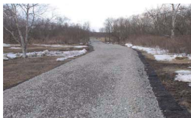
■右岸仮設道路状況
