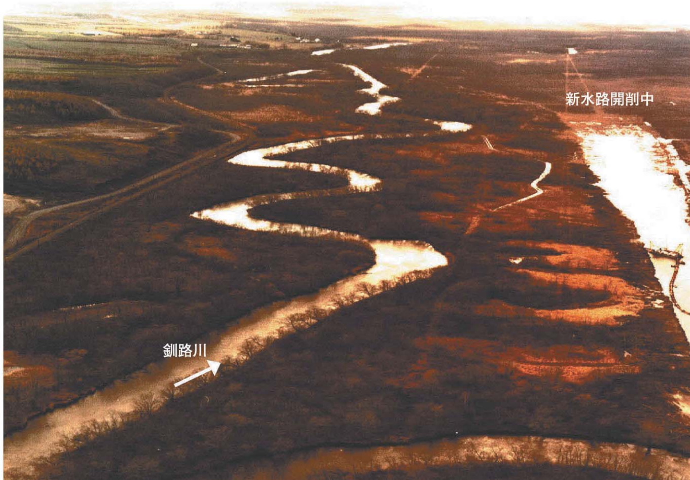
■新水路工事中(昭和51年撮影) 新水路事業は、オソベツ川合流点から下流約5kmの区間を対象に昭和48年に着工され、昭和55年に暫定通水、その後、新水路区間の河道拡幅を行い、昭和59年に完了しました。
