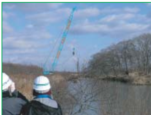
仮締切り用の鋼矢板を打込む重機(クレーン)
