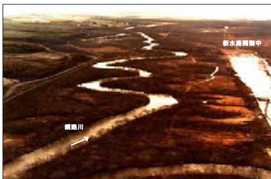
写真 3-1 新水路工事中（1976 年撮影）
