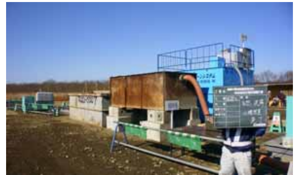
沈殿池・無機系凝集剤投入による濁水処理
