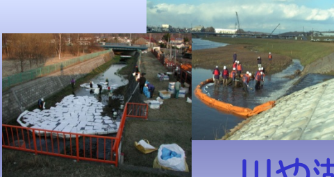
汚染物質の流出防止・回収
