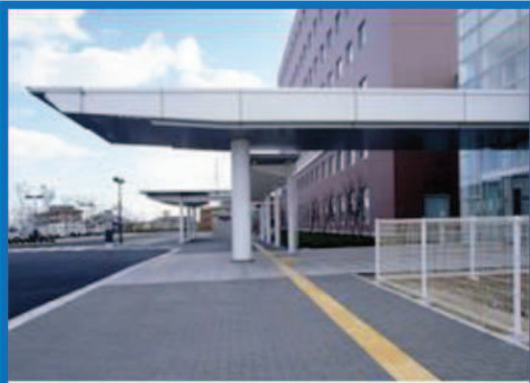
段差がなく、見通しのよいアプローチ通路 視覚障がい者誘導用ブロックの敷設
