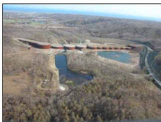
錦多峰川2号遊砂地(苫小牧市)
