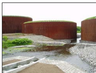
下流から見た鋼製セルえん堤
