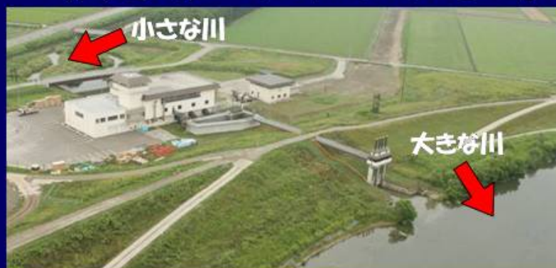
排水ポンプ場
