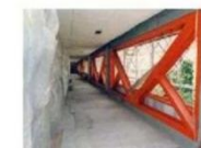
鉄骨ブレースによる壁の補強
