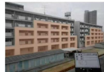
▲外付けフレーム耐震補強
