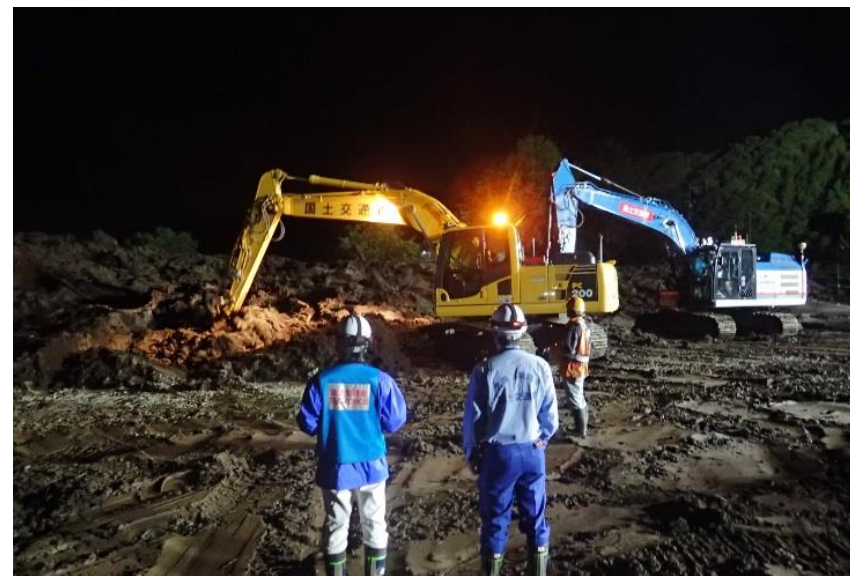
H30.9 胆振東部地震による河道閉塞土砂撤去〔厚真町〕
