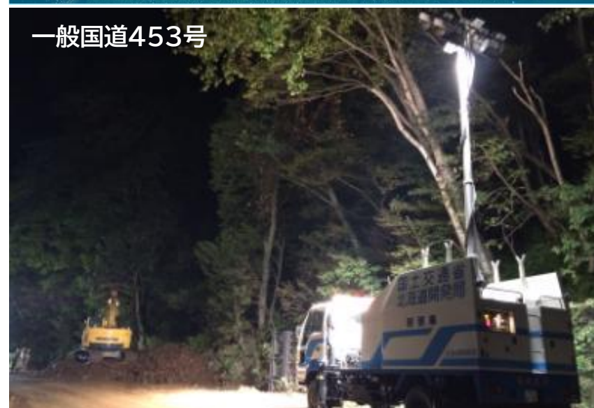
H26.9 大雨による土砂撤去作業支援〔千歳市〕
