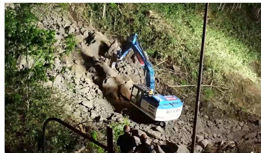
R4.3 一般国道276号岩盤崩落による岩塊除去〔千歳市〕
