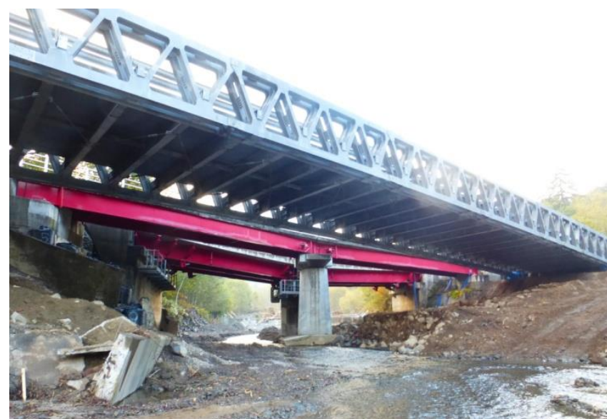
H26.9 一般国道453号 奥漁川橋架設状況〔恵庭市〕
