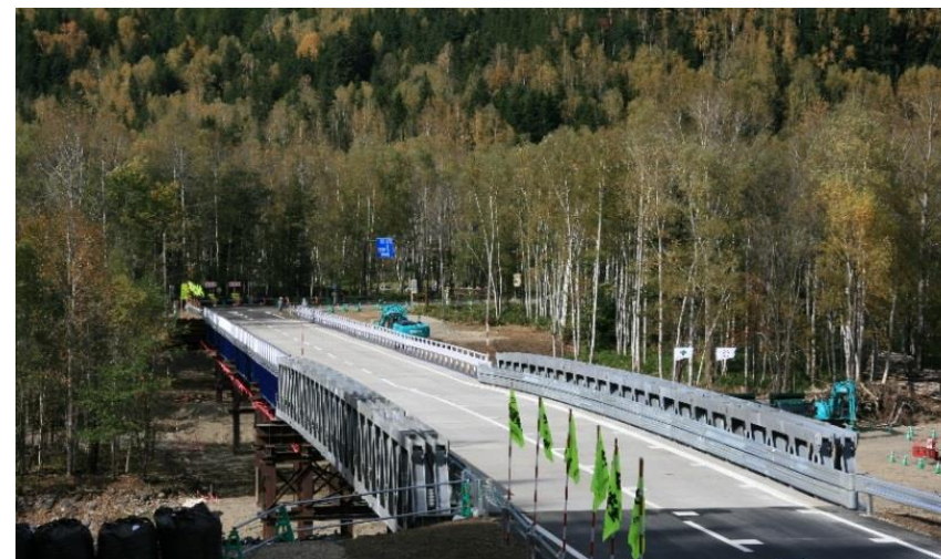
H28.8 一般国道273号 高原大橋架設状況〔上川町〕
