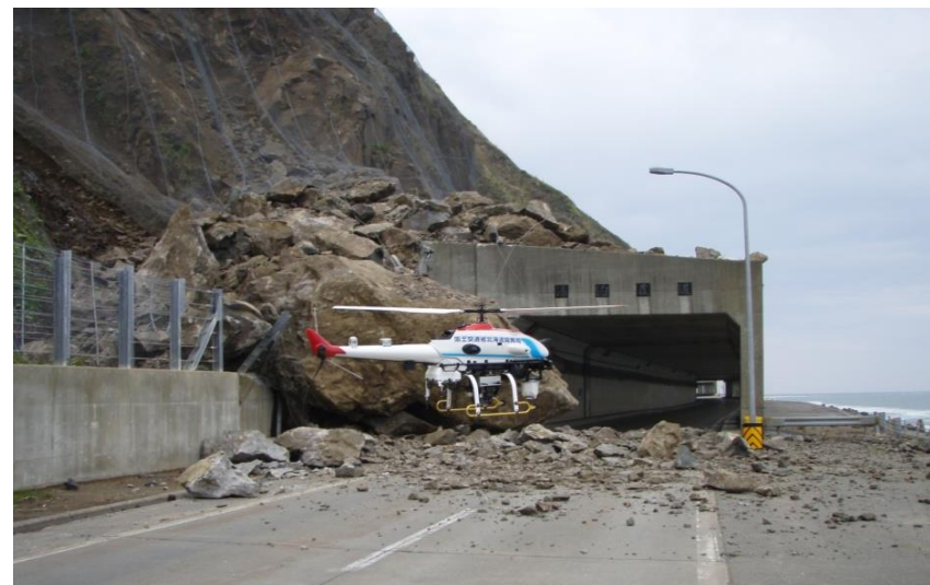
H20.5 一般国道231号 落石による出動〔増毛町〕
