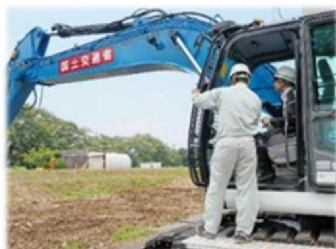
建設機械施工実習
