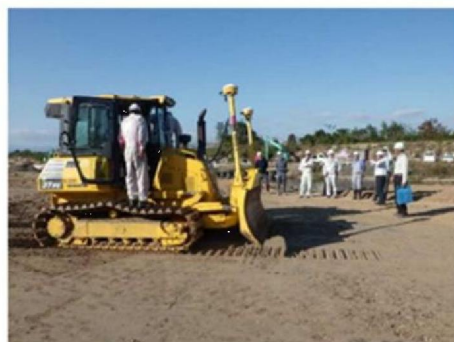
ICT-MC建機(ブルドーザ)の実践
