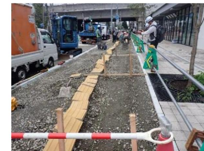
床堀(点字ブロック敷設)
