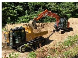
自動施工の高度化
