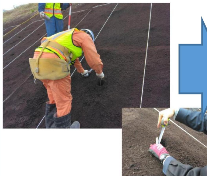
人力による出来形計測状況
