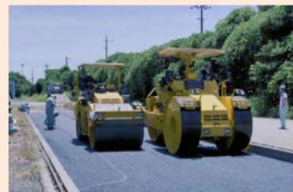
【車両等に取り付けた表面温度測定装置で計測】
