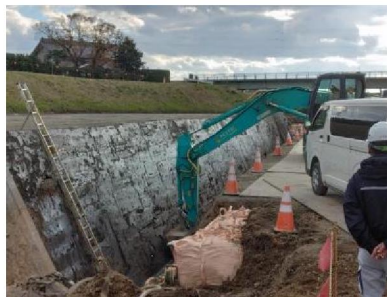
掘削法面整形
