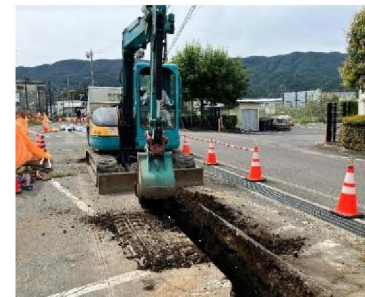
床堀(管路敷設)
