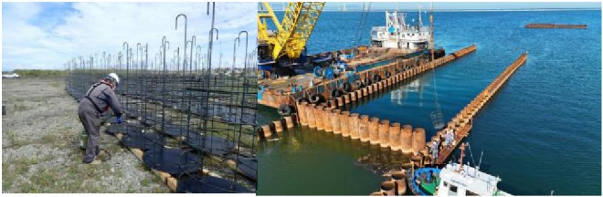
杭頭吊型枠設置(防錆処理)
