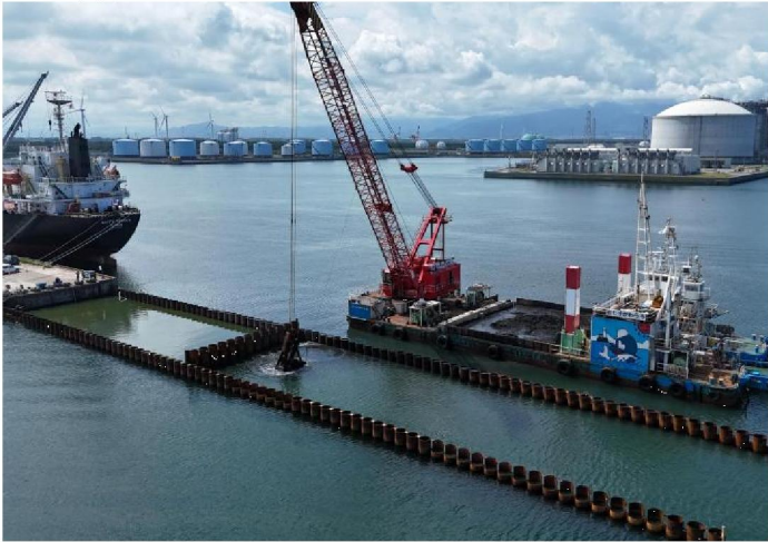
土砂積込(過積載防止管理)
