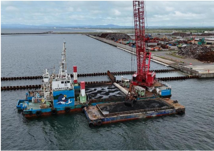
本土工 鋼管矢板切断
