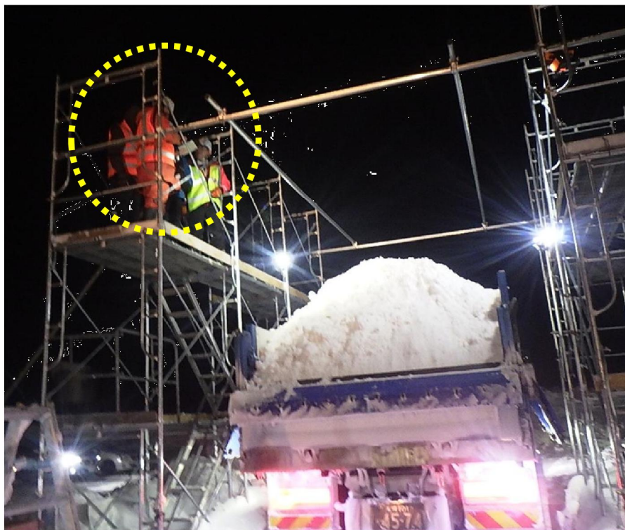
足場上から計測
