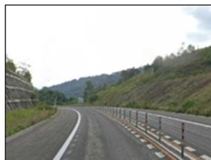
写真-2 ワイヤロープ式防護柵設置状況
