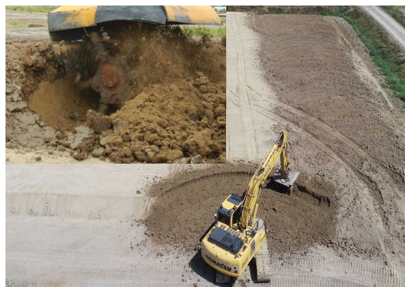
図-2 土砂混合攪拌での GNSS 活用
