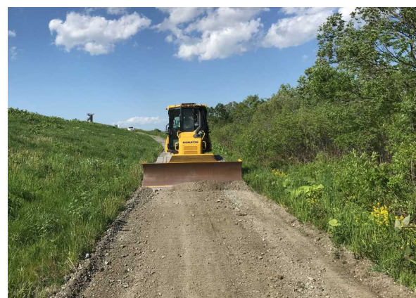
図-3 ICT 土工を応用した敷砂利の施工
