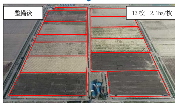
写真-1 事業実施前後の状況
