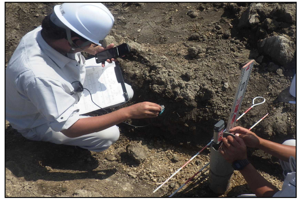
写真-2 暗渠排水工疎水材厚さの撮影状況
