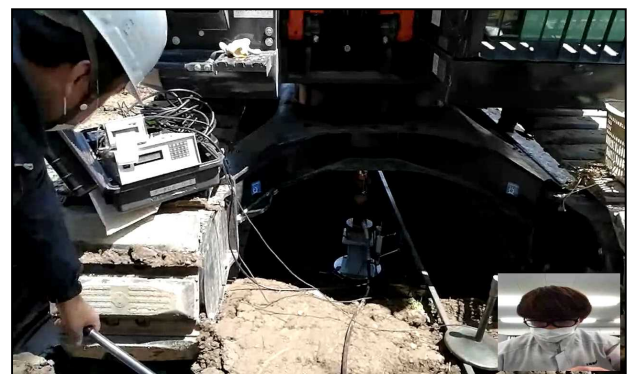
写真-4 木杭載荷試験の確認状況(日陰箇所)
