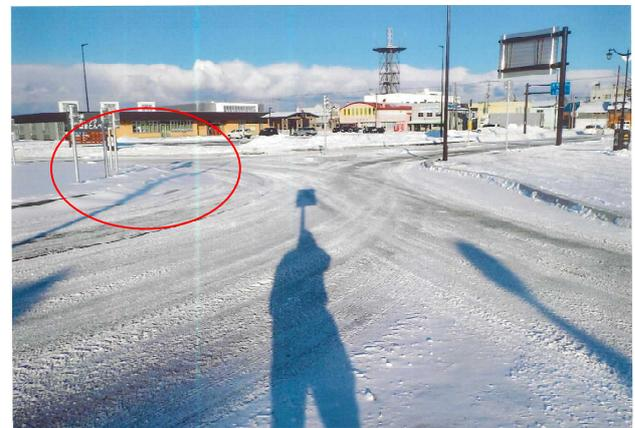
写真-3 中央島の少量の雪でも発生する吹き溜まり
