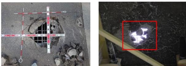
写真-2 床版抜け落ち状況
