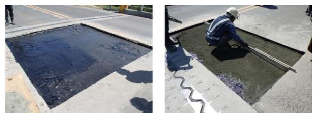
写真-6 応急復旧状況1（左：防水層、右：敷モルタル）
