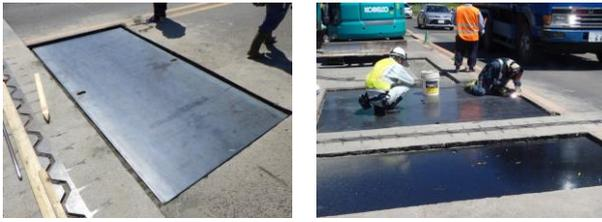
写真-7 応急復旧状況2 (左：敷鉄板、右：敷鉄板溶接)
