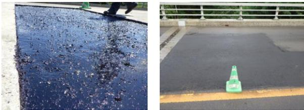
写真-9 応急復旧状況4 (左：舗装材近接、右：表層完了)
