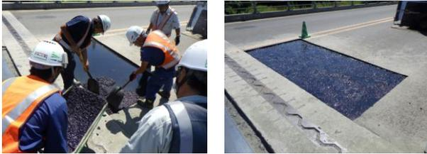
写真-8 応急復旧状況3 (舗装材舗設)
