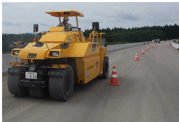
写真-7 本施工時の様子
