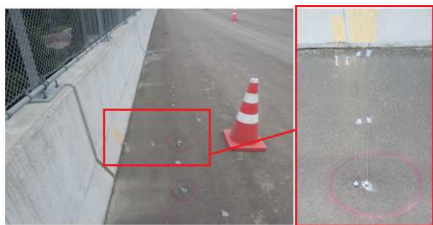
図-6 No. 1 電極設置状況
