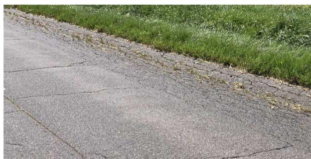
写真-3 路面の沈下および亀甲状のひび割れ
