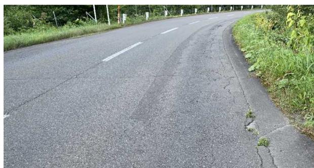
写真-2 路面の沈下および不陸
