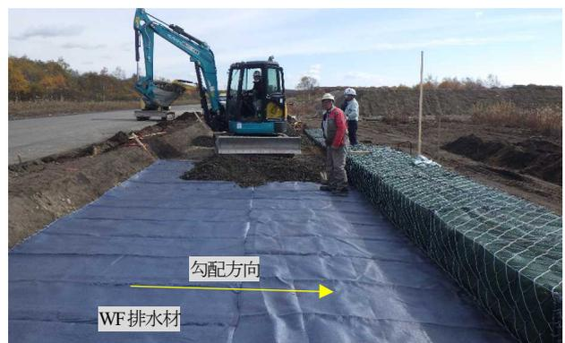
写真-5 WF排水材の継ぎ目処理
