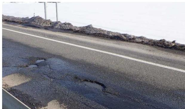
写真-1 舗装のひび割れおよびポットホール
