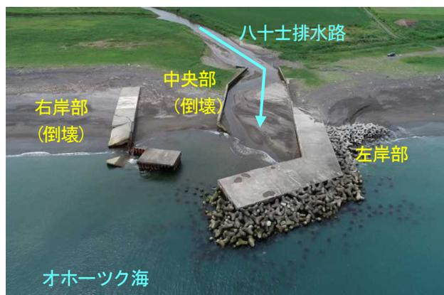
写真-1 対象導流堤の倒壊状況 (H30撮影)
