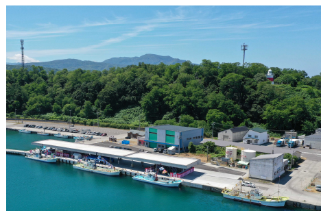
写真-1 物揚場（-3.5m）（船溜）の屋根付き岸壁
