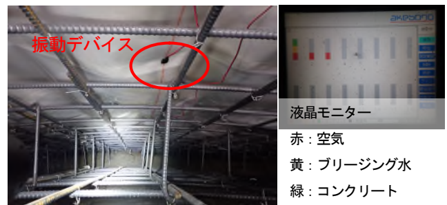
写真-3 覆工充填確認状況
