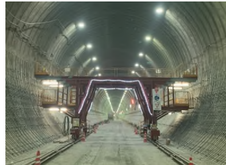
写真-1 移動式鉄筋足場台車
