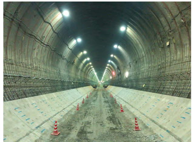
写真-2 インバート③打設完了全景
