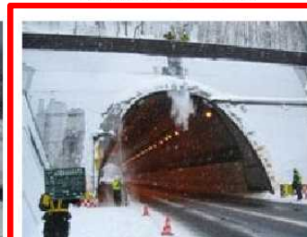
トンネル坑口の雪落とし作業
