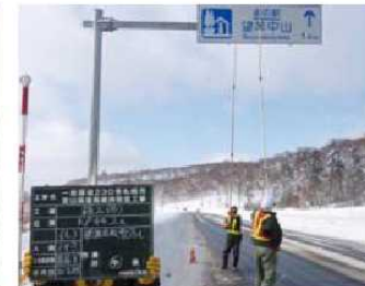
道路標識の雪落とし作業
