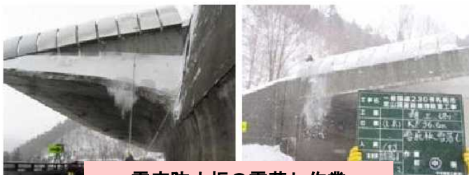
雪底防止板の雪落とし作業
