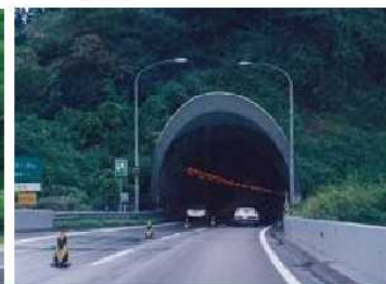
突出型坑口(北陸自動車道・福井県)
