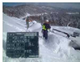
雪崩防止柵の雪落とし作業
