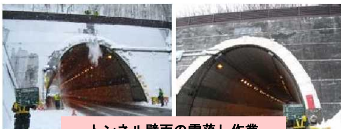
トンネル壁面の雪落とし作業
