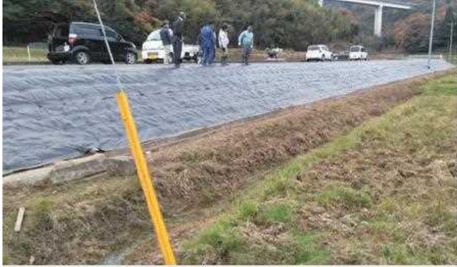
2019年12月上旬 ベた〜とシート施工
