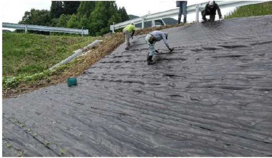
2021年6月中旬 ベた〜とシート施工
