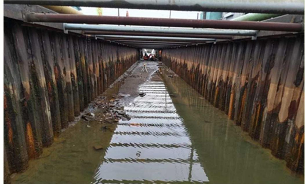
1)、2) どちらの場合も一般的に無防食の鋼矢板水路が年数の経過とともに腐食し性能低下を引き起こしその結果構造的に不安定となる。
