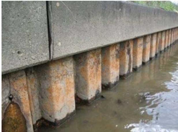
2) 切梁式鋼矢板護岸の腐食状況
