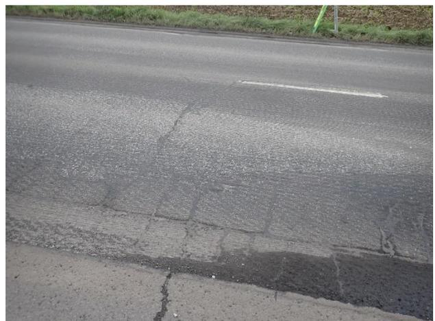
写真-3 一般国道276号倶知安町の切削後の路面状況
