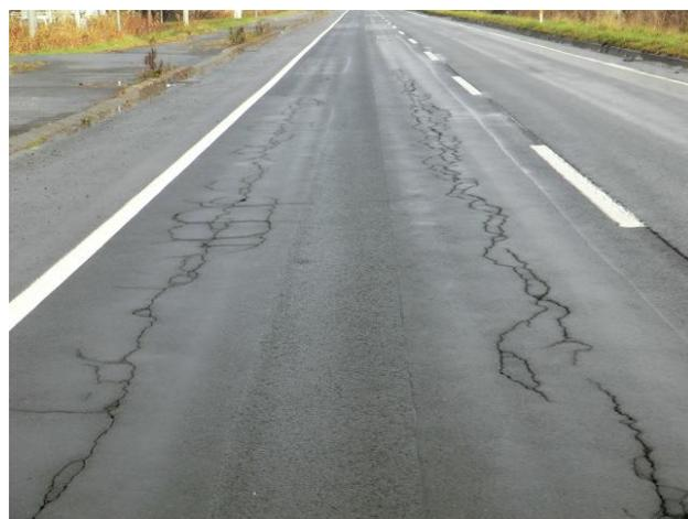
写真-1 疲労ひび割れによる損傷事例
