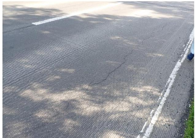
写真-2 一般国道44号厚岸町の切削後の路面状況
