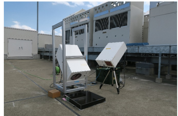
写真5 夏期試験状況 (マイクロ波、昼間)
