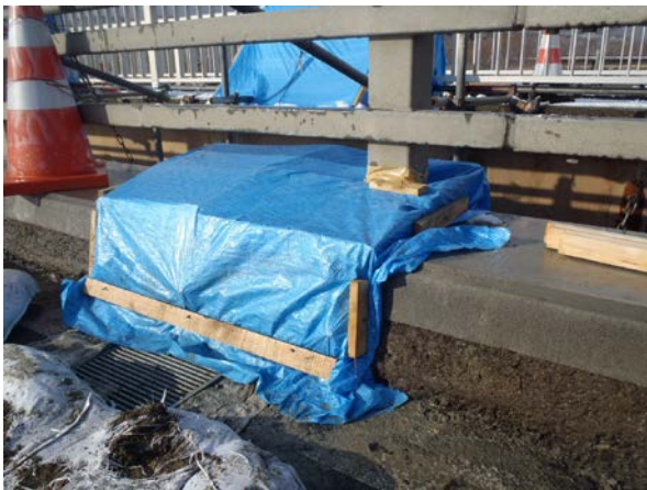
写真-3 ブルーシート養生
