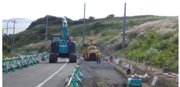
写真-1 試験施工箇所（登坂車線設置工事）
