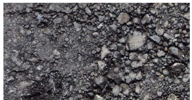
写真-3 調査前日施工箇所の凍上抑制層上面の状態
