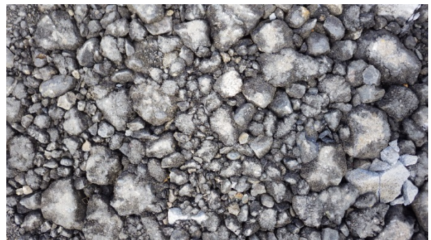
写真-2 調査日施工箇所の凍上抑制層上面の状態
