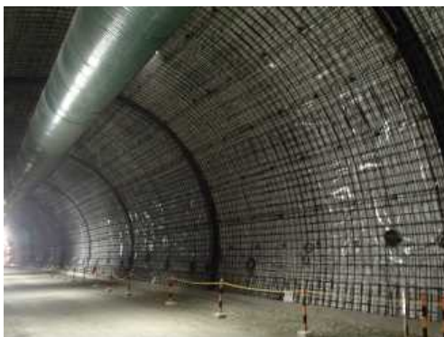
写真-13 アーチ鉄筋工完了全景
