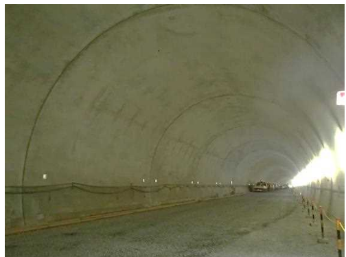
写真-15 アーチコンクリート工完了全景
