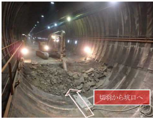
写真-1 インバート掘削状況写真
