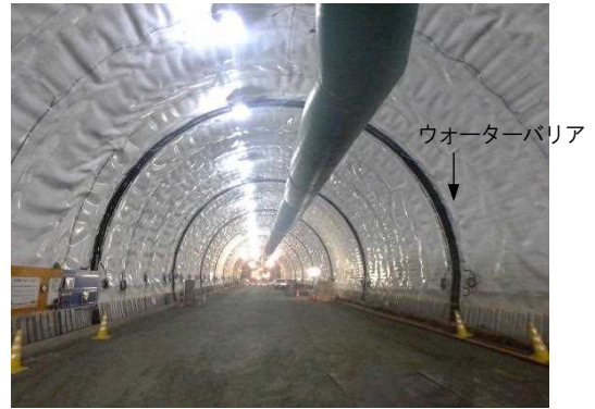
写真-9 アーチ防水工完了全景
