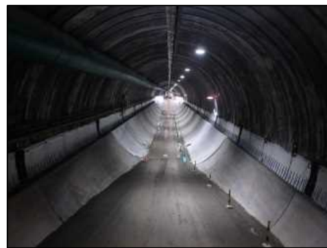
写真-6 側壁コンクリート完了全景
