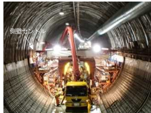
写真-5 コンクリート打設状況
