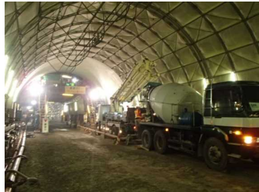
写真-14 アーチコンクリート打設状況
