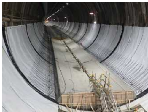
写真-2 インバート完了全景写真
